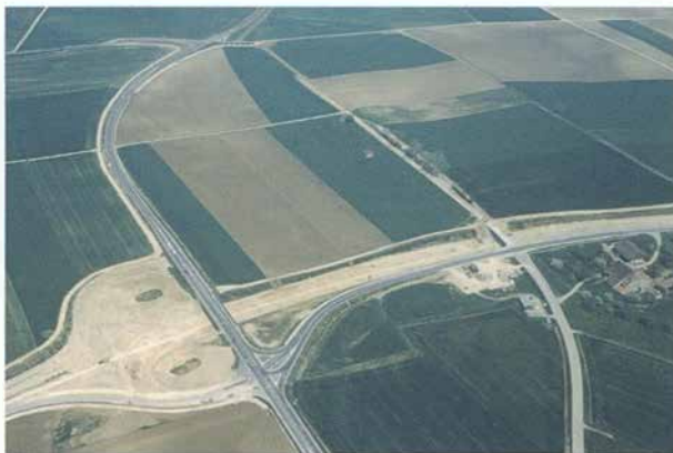
Fig. 4. Le site de Boscéaz se dessine au printemps 1987, entre l'autoroute en construction et la route cantonale déjà détournée. Sud-ouest de la pars rustica . Vue en direction du nord.
