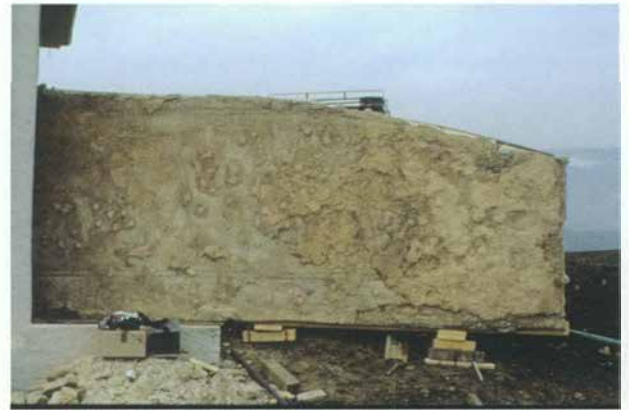
Fig. 7. Aux grands maux, les grands remèdes: la mosaïque du Cortège rustique, très altérée, est prélevée en une pièce en 1998. Elle est extraite du bâtiment construit en 1841 pour aller subir un traitement en laboratoire. On voit ici la face inférieure du tapis de cubes, avec des restes de mortier injectés à diverses époques.
