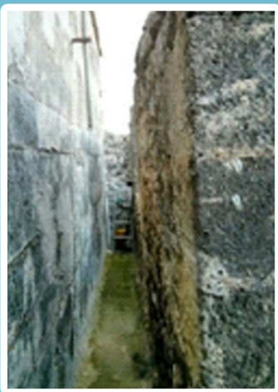
Le double parement visible sur le chemin de ronde
