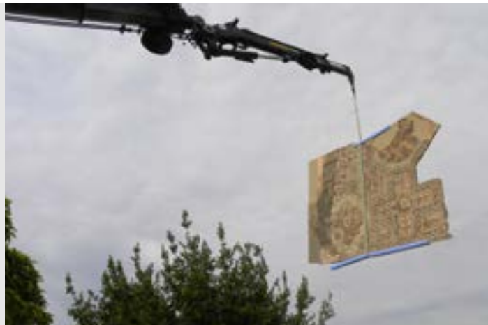
Arrivée sur le site des panneaux de mosaïque. Lors de leur dépose, les pavements avaient été découpés en 25 panneaux.
