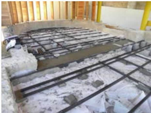
Préparation du support sur lequel seront reposés les pavements de mosaïque.
