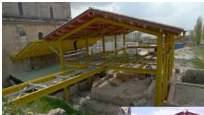
Etapes de construction de la halle-plateforme.
