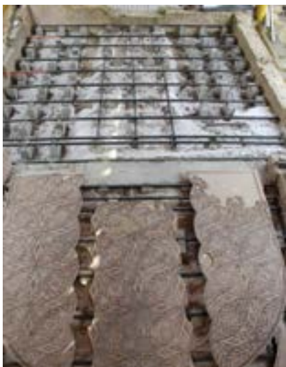
Préparation du support sur lequel seront reposés les pavements de mosaïque.
