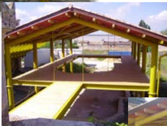
Sa fonction est de protéger et de valoriser la mosaïque recouvrant le sol d'une salle d'apparat.
