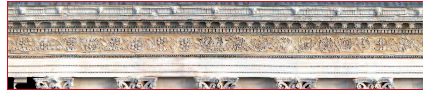
Frise et corniche après restauration
