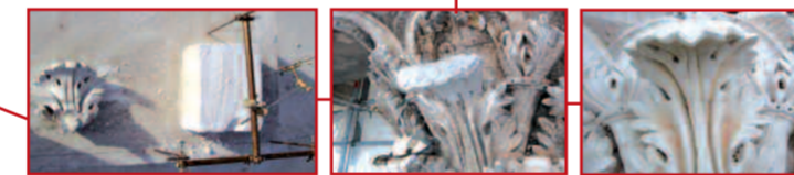
Remplacement à l'identique d'une extrémité de feuille d'acanthé de chapiteau
