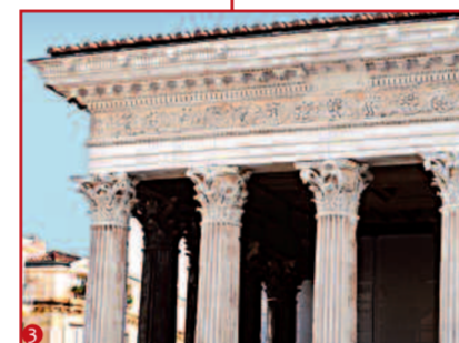
① ② Angle ouest du fronton nord, nettoyage et consolidation des restaurations de F. Estouin, dit Armand, sous la direction de J.-F. Séguier en 1781 ③ Zone après restauration
