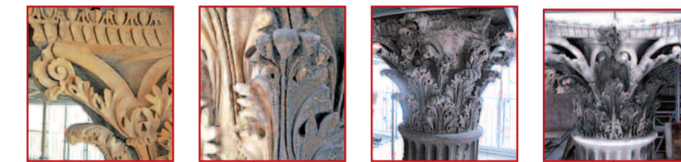
Exemples d'altérations de chapiteaux et de colonnes avant restauration
