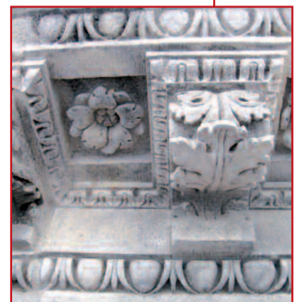
Modillon refait à l'identique en pierre de Lens.
