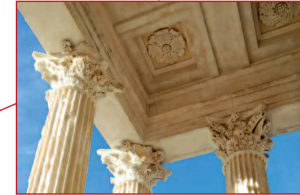
Vue du fronton nord avec son plafond à caisson du XIX e siècle après restauration
