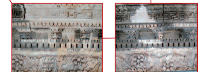
Détails de la frise et de la corniche avant restauration
