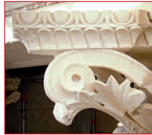
Partie refaite à l'identique
