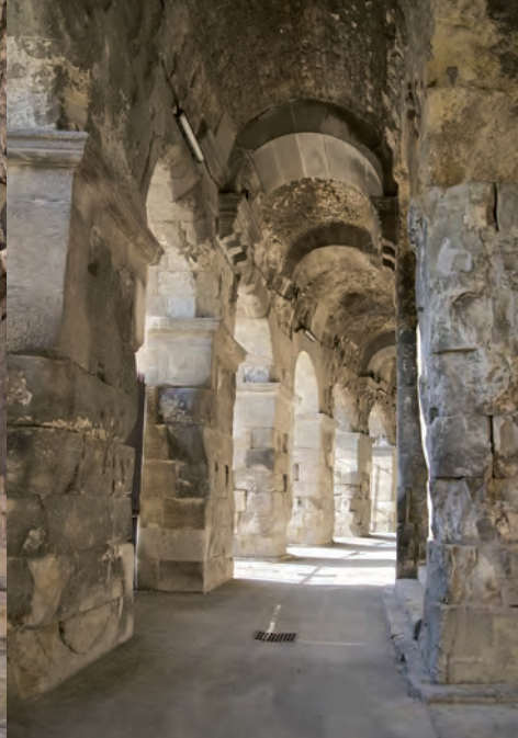
Galerie rayonnante. (Photo du haut) Galerie circulaire au rez-de-chaussée.
