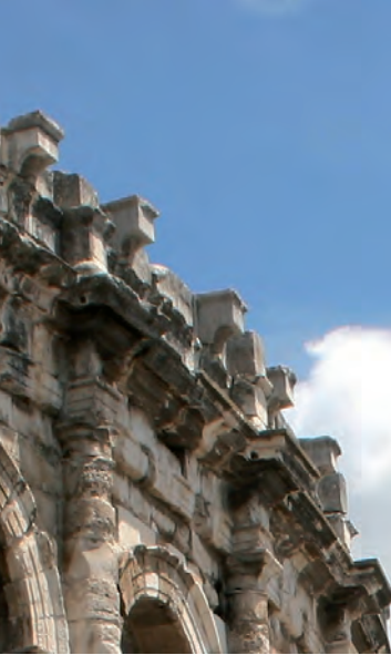
Attique avec les consoles pour le velum.
