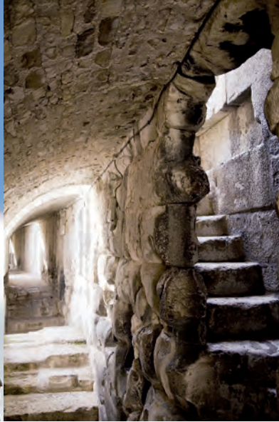
Escalier de service.
