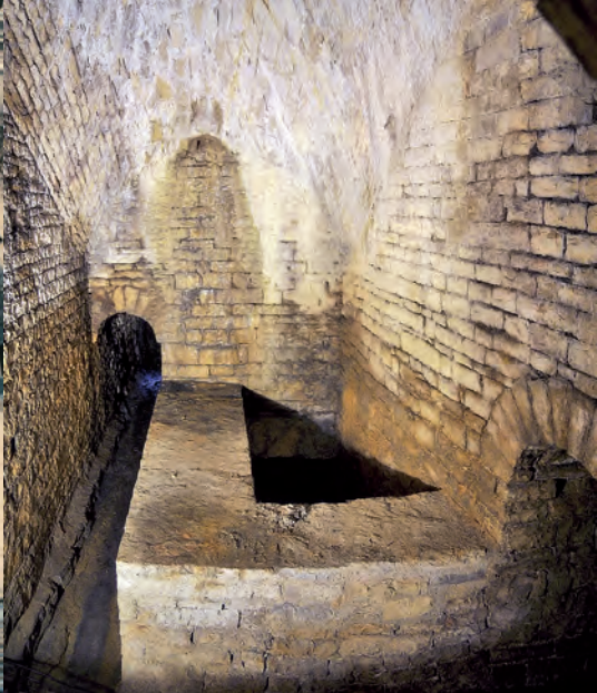
Egout et bassin de décantation.
