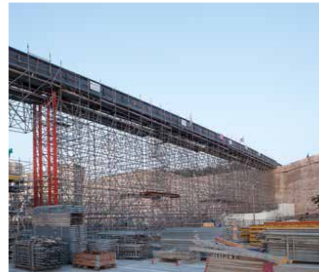
29/08/2011 , Photo Olivier Amsellem - OPPIC Mucem. Chantier au 29 août 2011.
