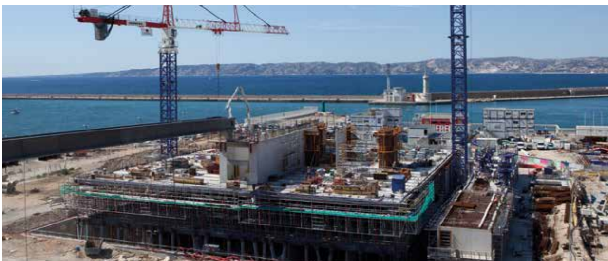
29/08/2011 , Photo Olivier Amsellem - OPPIC Mucem. Chantier au 29 août 2011.
