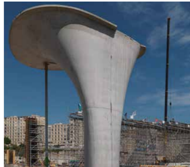
13/06/2011 , Photo Olivier Amsellem - OPPIC Mucem. Chantier au 13 juin 2011.
