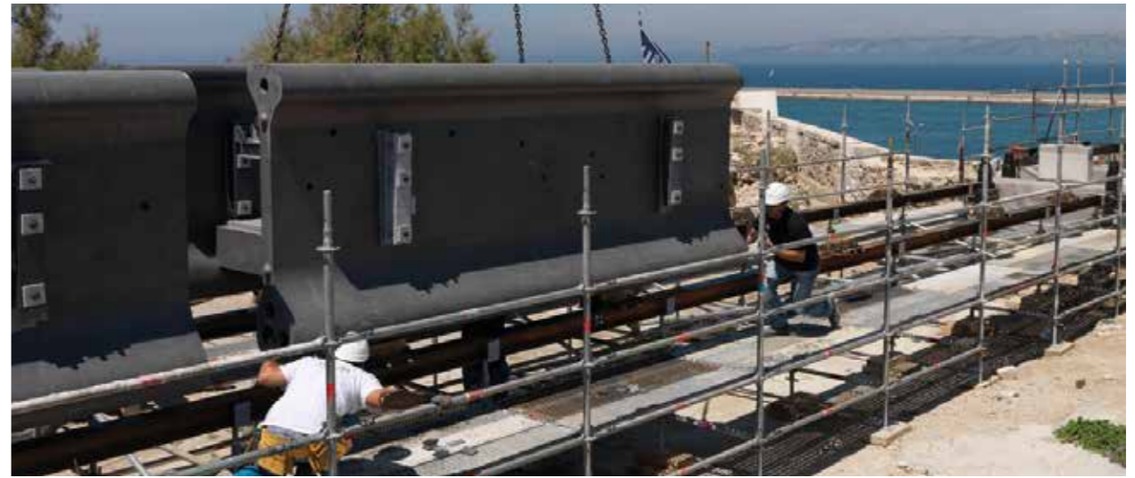
13/06/2011 , Photo Olivier Amsellem - OPPIC Mucem. Chantier au 13 juin 2011.
