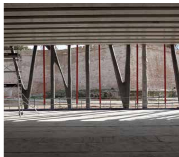
15/11/2011 , Photo Olivier Amsellem - OPPIC Mucem. Chantier au 15 novembre 2011.
