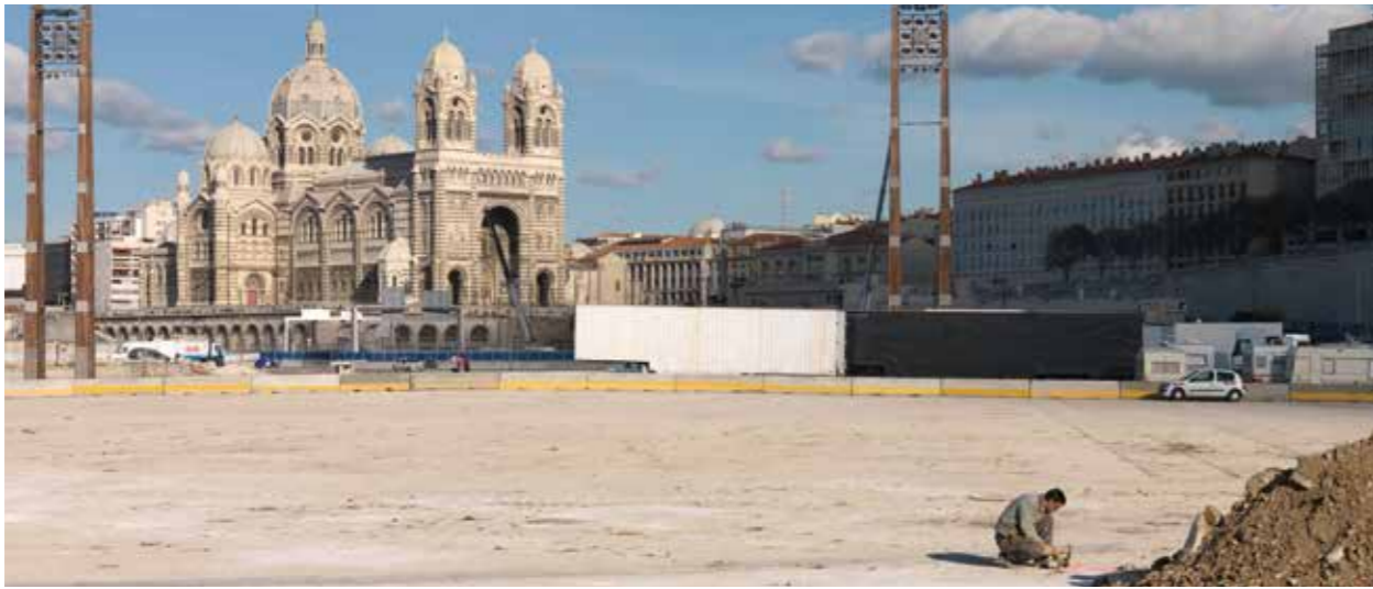
23/11/2009 , Photo Olivier Amsellem - OPPIC Musée des Civilisations de l'Europe et de la Méditerranée. Môle J4 futur emplacement du bâtiment du Mucem (architecte Rudy Ricciotti), début du terrassement, angle Nord Est. 23 novembre 2009.
