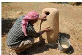
4. Fabrication d'un silo à grains en terre crue, région de la Bekaa, Liban / Syrie, 2020. Mucem © Hoda Kassatly
