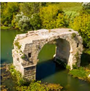
Ce pont comptait entre 9 et 11 arches pour une longueur totale de plus de 150 m. Il permettait à la Via Domitia de franchir le Vidourle. Sans doute l'un des plus anciens ponts de la région, il aurait été construit aux alentours du changement d'ère. Encore utilisé au Moyen-Âge (construction d'une
