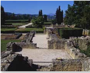
Vue sur la villa depuis l'angle nord des appartements d'été
