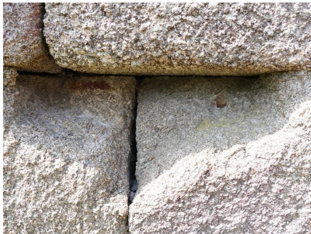
Traces d'agrafe visibles dans les angles des blocs © CD 53
