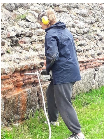
Carottage dans une brique
