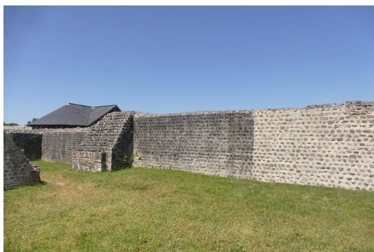
Mur intérieur du bâtiment central en cours de nettoyage (avant /après)
