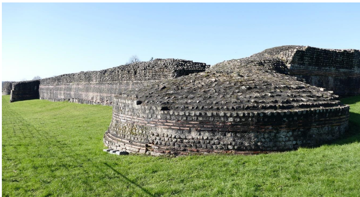
Côté sud de la muraille de la forteresse © CD 53
