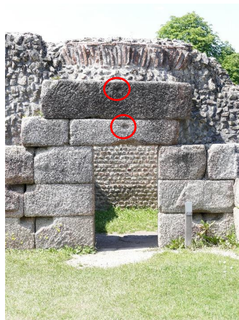
Creusement sur la face supérieure du bloc au premier plan à gauche indiquant l'utilisation de la louve © CD 53
