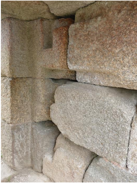
Encoches en forme de L renversé visibles à l'intérieur du passage de la porte de la tour sud-ouest
