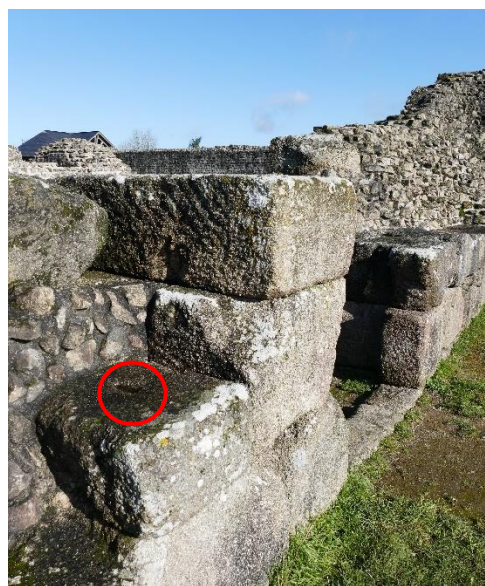
Creusement sur la face supérieure du bloc au premier plan à gauche indiquant l'utilisation de la louve © CD 53
