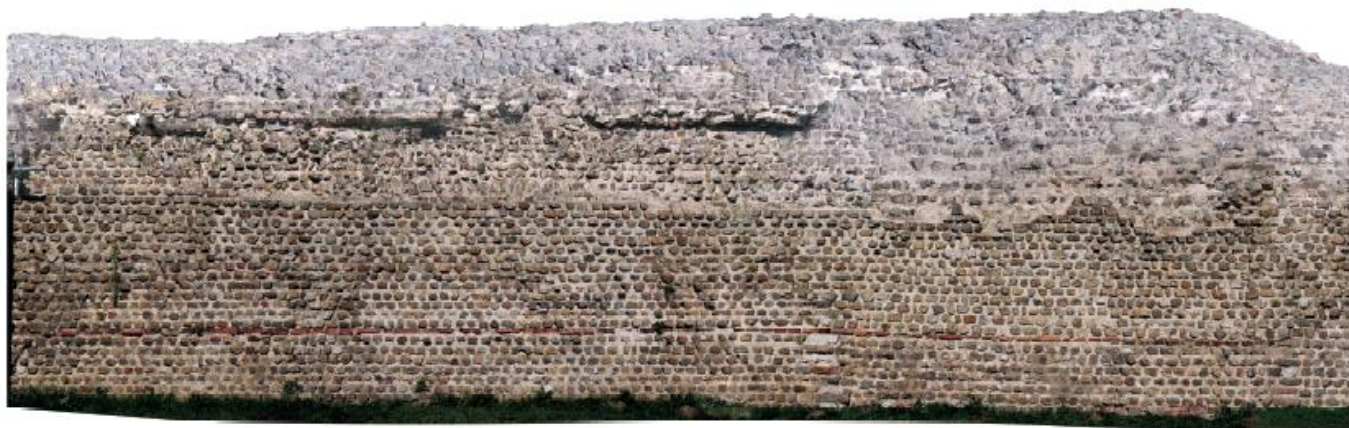
Photogrammétrie du parement interne d'un tronçon de la courtine nord-ouest, © Virtual-Archeo DAO Yann Bernard
