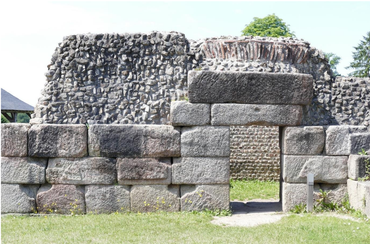
Mur de la tour d'angle sud-ouest © CD 53
