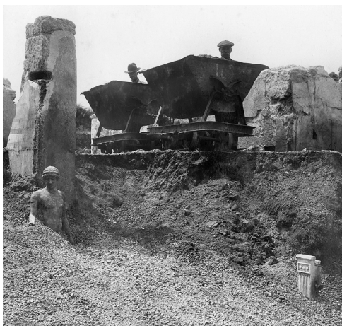
Fouilles dans la maison de l'Éphèbe, 1925, photographie, Pompéi, Parc Archéologique de Pompéi
