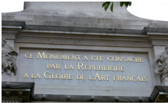
III.26 Dédicace du Grand Palais. Façade sur l'avenue Franklin D. Roosevelt. 1900.
