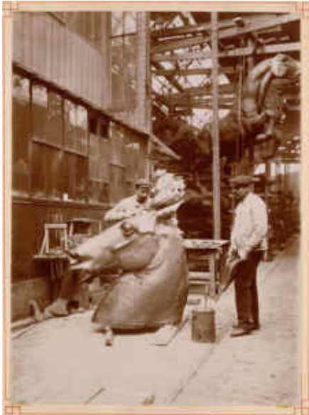
▲ Les premiers assemblages dans l'atelier Monduit, 1899, photographie, Paris, Musée d'Orsay
