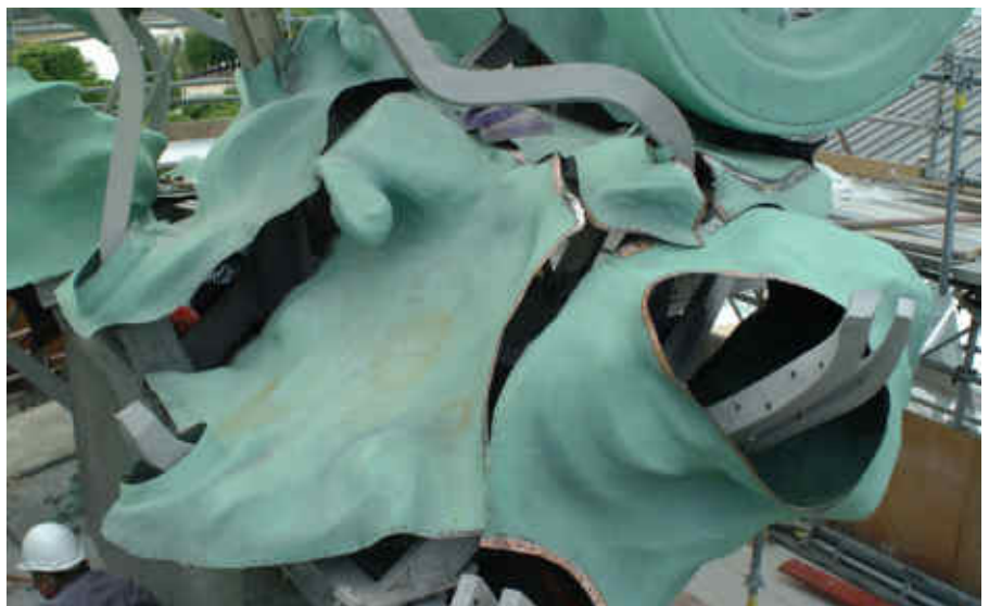
▲ Détail de l'assemblage sur la nouvelle armature
