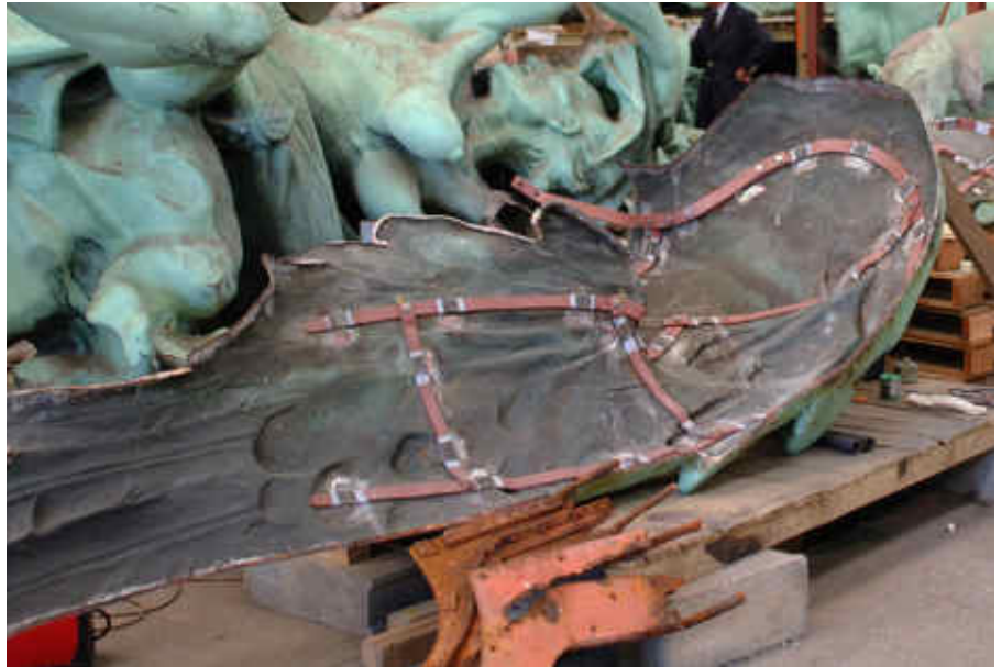
▲ Détail de la nouvelle ossature de l'aile du Temps
