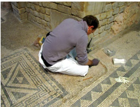
2009 - Intervention de restauration sur la mosaïque
