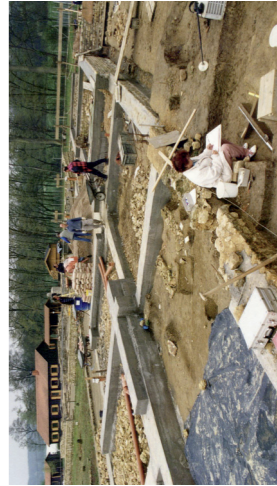
Premiers murs de fondation pour la reconstruction des bains
