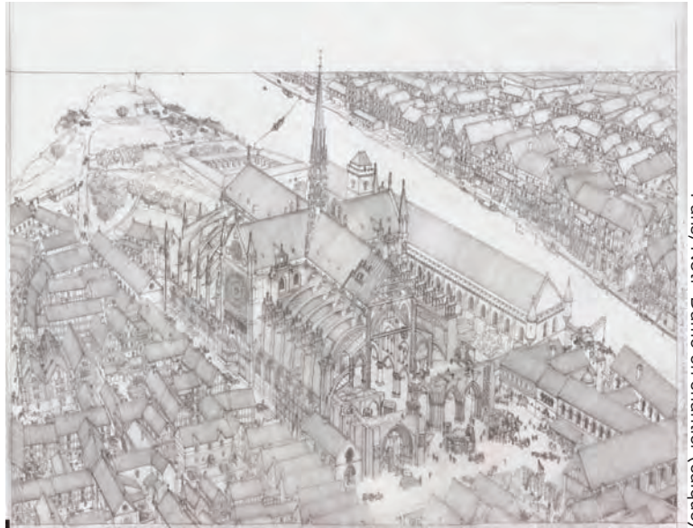
Paris, Notre-Dame en chantier (calque)
