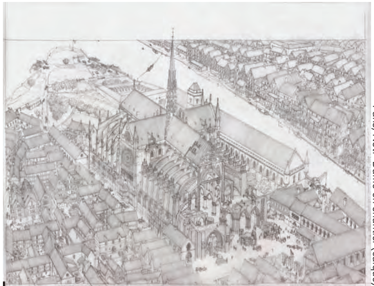
Paris, Notre-Dame en chantier (calque)
