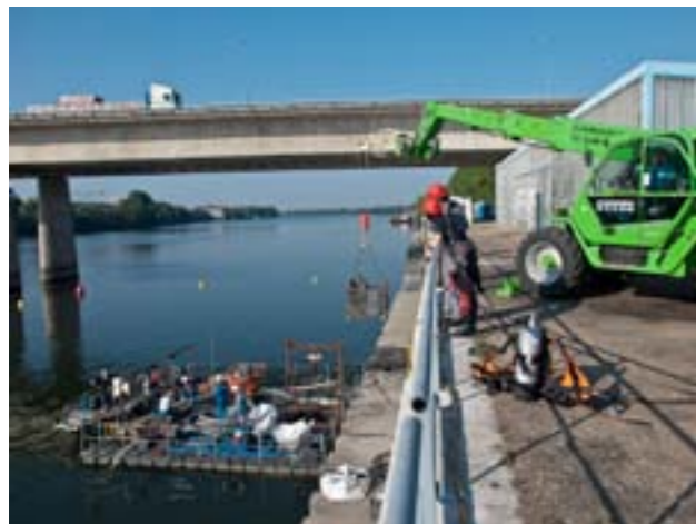
Ci-contre : vue de l'installation du chantier, avril 2011 © T. Seguin
