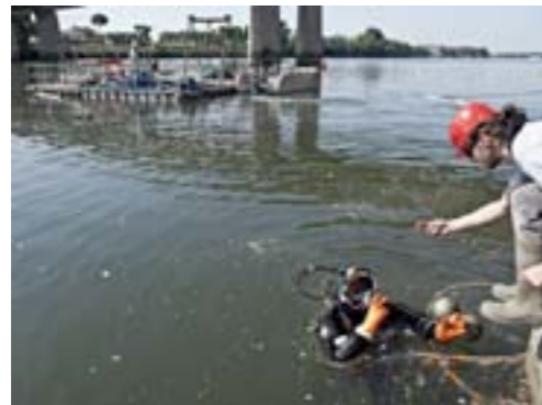
Mise à l'eau d'un scaphandrier.
