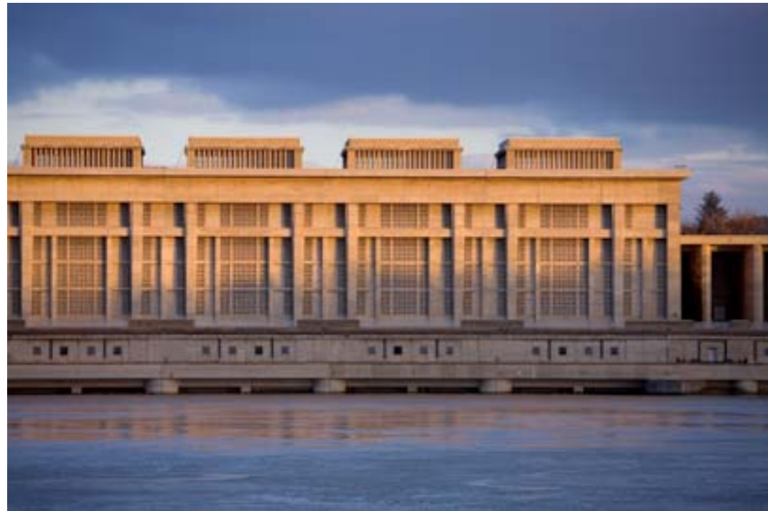
Centrale hydroélectrique André-Blondel de la CNR à Bollène (Vaucluse) © C. Moirenc
