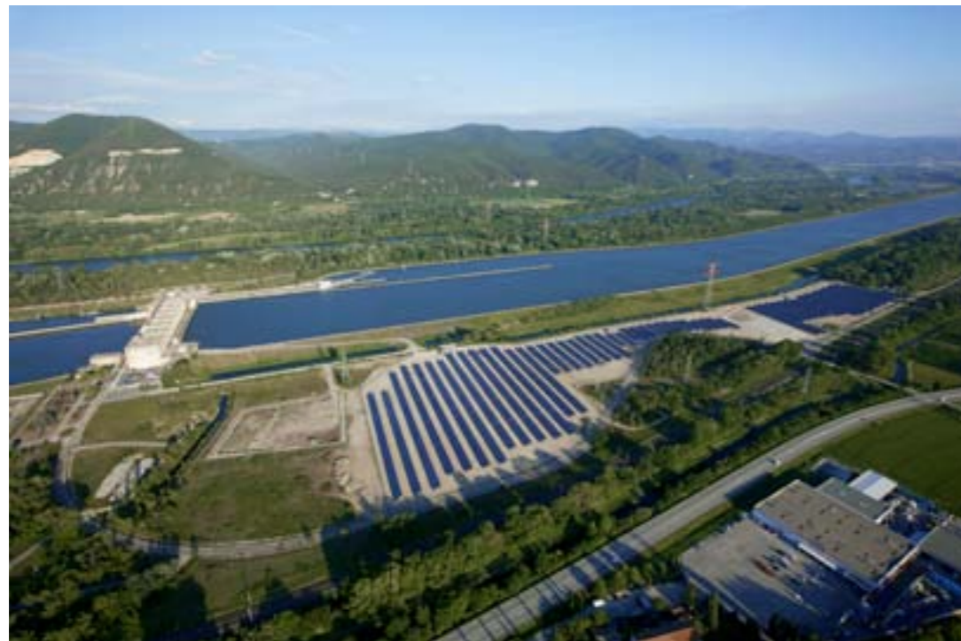
Parc photovoltaïque de la CNR à Saulce-sur-Rhône (Drôme) © C. Moirenc
