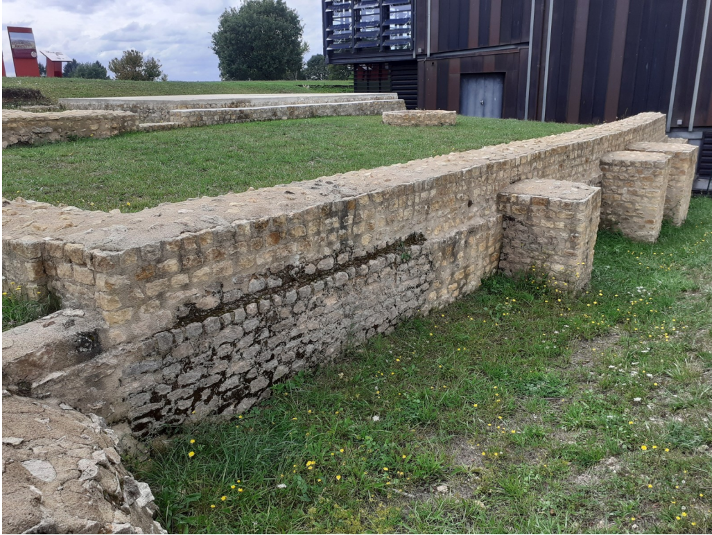
Contreforts de la domus
