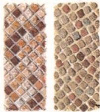
1 Première technique de construction des murs à Pompéi. Moellons maintenus par des blocs de tuf.
